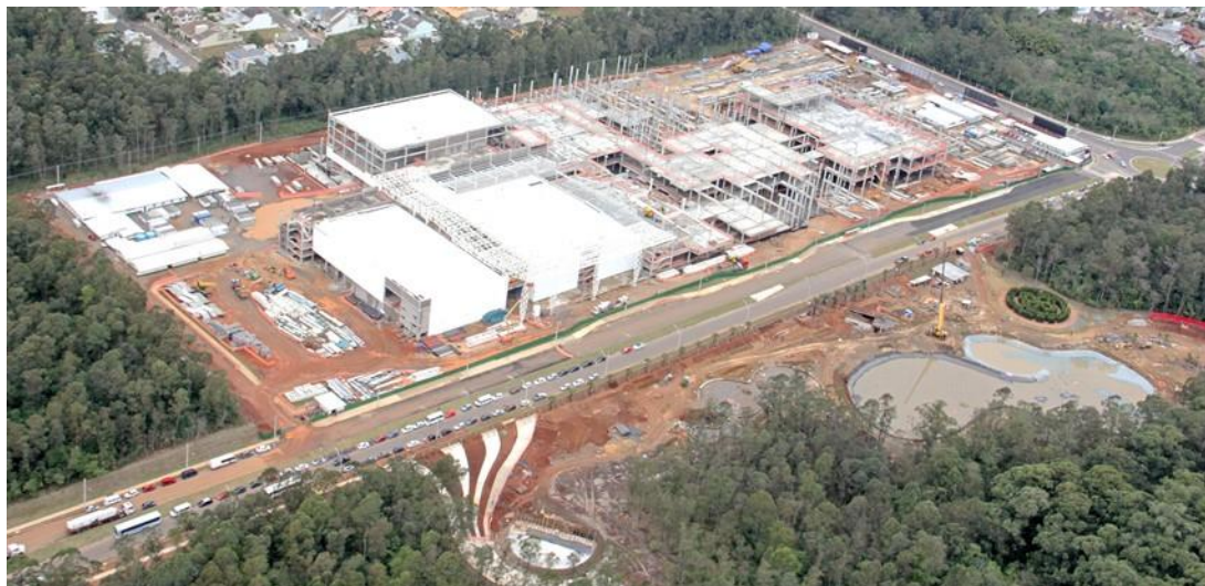
ParkShoppingCanoas em construção
