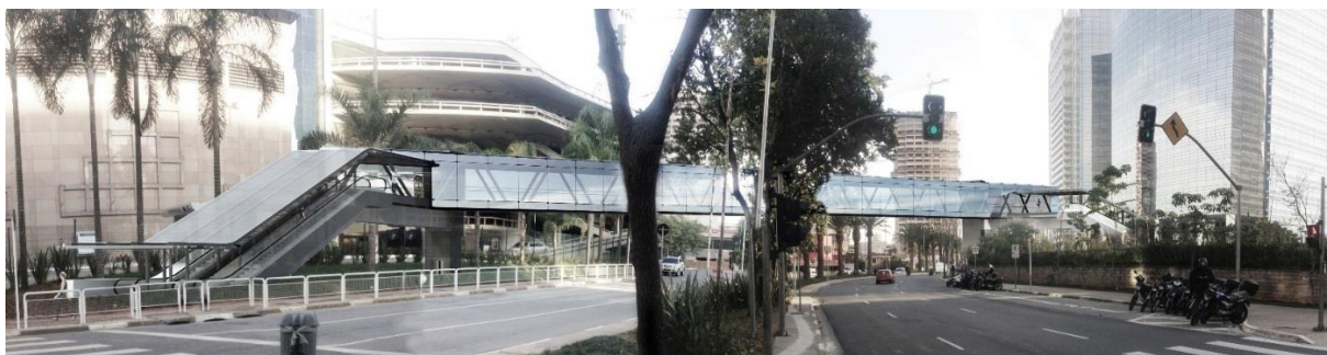
Ilustração da passarela em construção, que integrará o MorumbiShopping ao Morumbi Corporate
