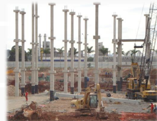
Construção do ParkShoppingSãoCaetano (SP)
