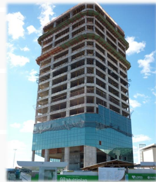
Construção do Cristal Tower (RS)
