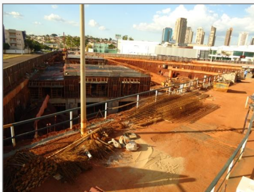
Centro Profissional RBS (SP) Obras no 1T11
